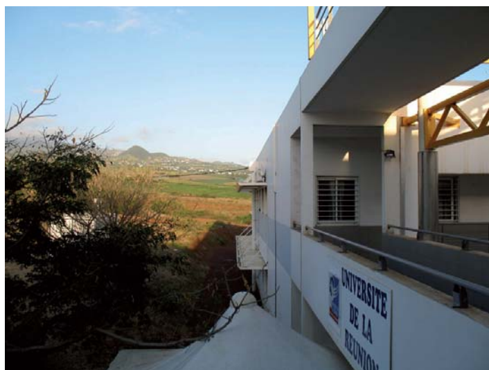
Photo(s) du bâtiment : Bâtiment de l'IUT saint Pierre La Réunion
